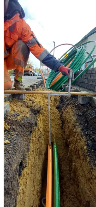
Offene Bauweise im Pflaster
