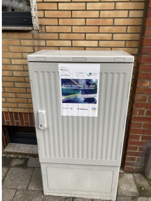
Glasfaserverteiler
